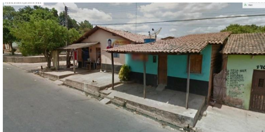
Figura 3.2.5. Esquina Av. Francisco Vitorino da Assunção e R. João Lula, Parque Pauí, novembro de 2011. FONTE: Google Earth
