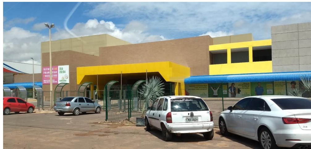
Figura 3.4.1. Shopping Cocais – Polo Gerador de Viagens, junho de 2017 FONTE: CERTARE
